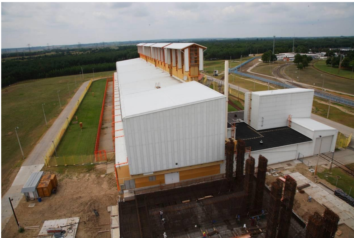
A Kiegészített Kazetták Átmeneti Tárolója
