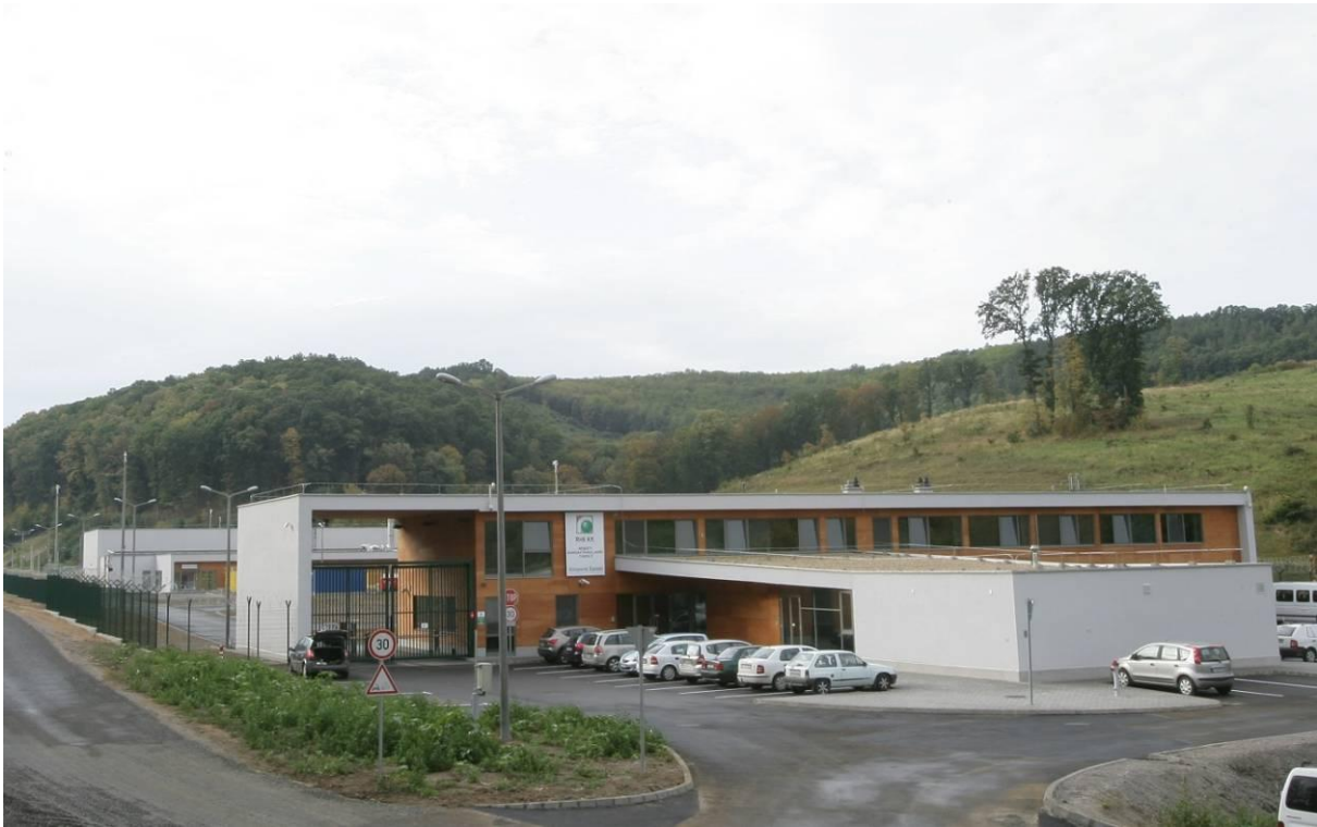
A Nemzeti Radioaktív Hulladék-tároló felszíni épületei
